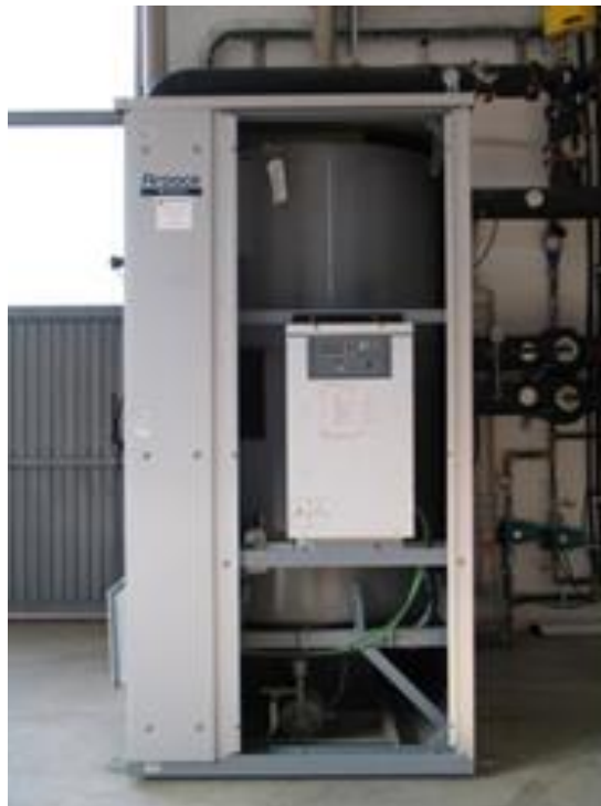
Figura 10. Máquina de absorción de simple efecto Yazaki WFC SC 20.
